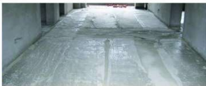
6 - 填充层施工完成
